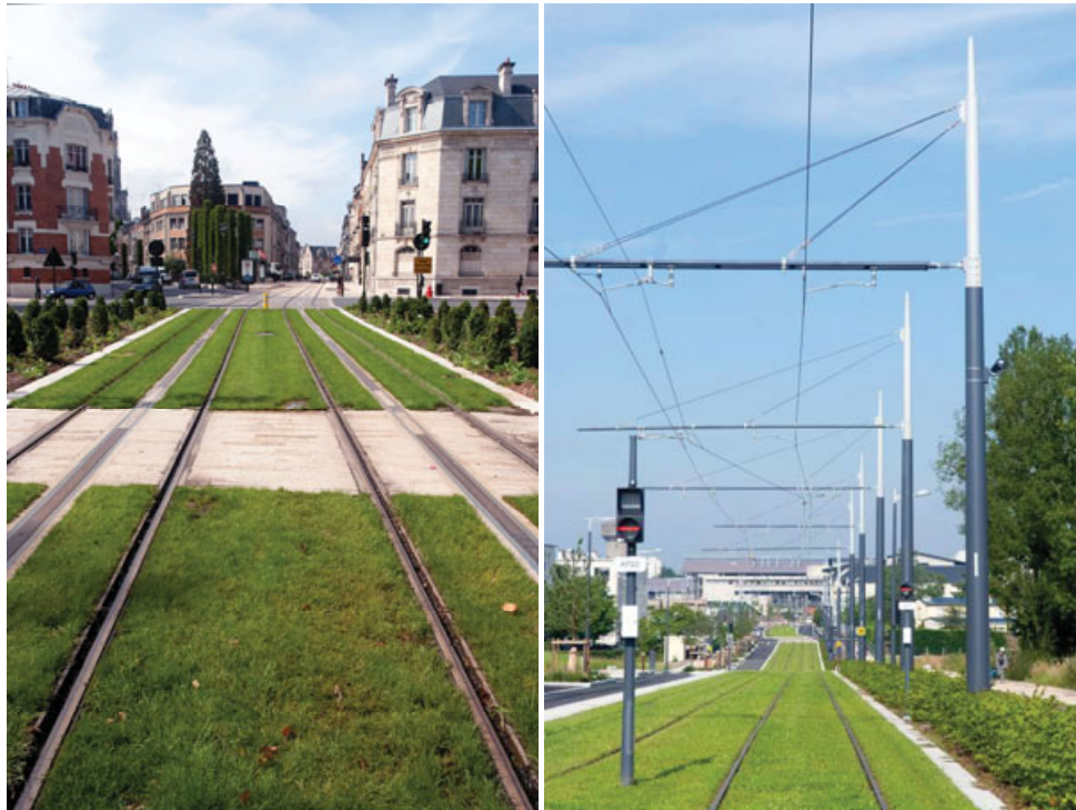
Figure 4 : Plateforme engazonnée et plantations place Halmagrand et boulevard Marie Stuart. Crédit photo : Olivier Marcu
