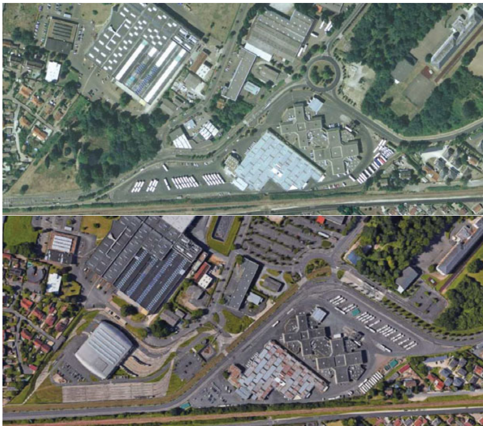
Figure 82 : Site du centre de maintenance en 2006 et 2016
