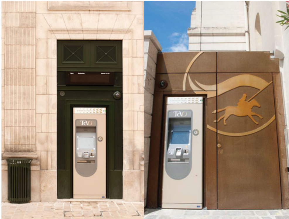
Figure 3 : insertion discrète des équipements aux stations Jeanne d'Arc et Cathédrale – Hôtel de Ville. Crédit photo : Olivier Marcu
